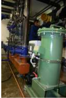
Eine Filteranlage während der Montage
